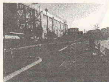
③北西の正門前より南西方向を見る
