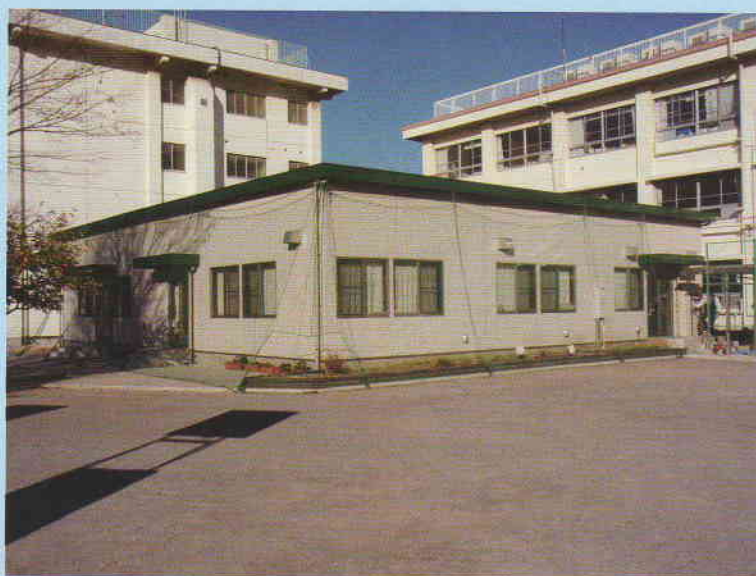
松上小学校校庭から見た管理棟の全景
